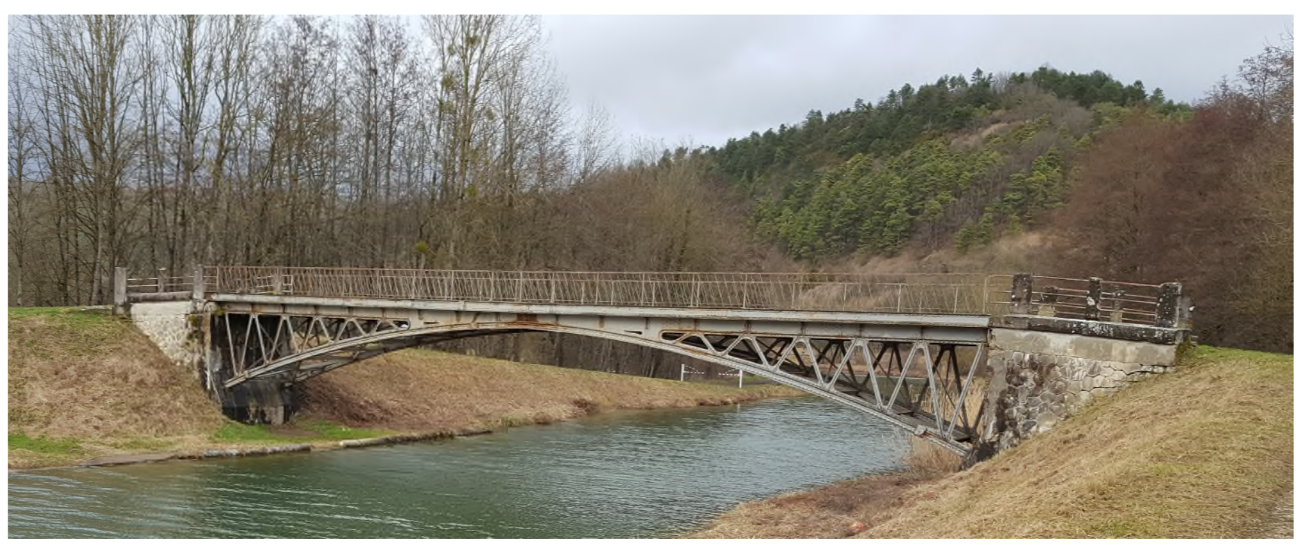
Pont sur canal au-dessus du canal EXISTANT
